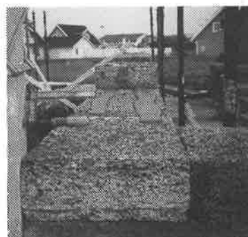
Figur 18. Murning med träullsblock
