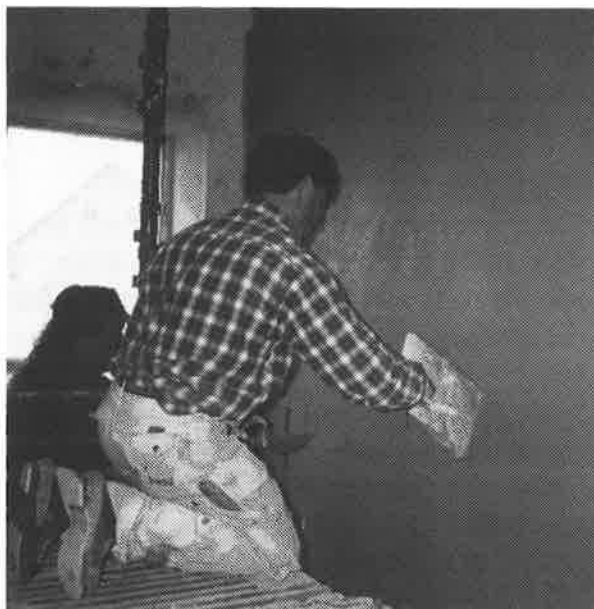
Figur 27. Innerväggarna består av en stålregelstomme med gips, träullsplatta samt puts.
