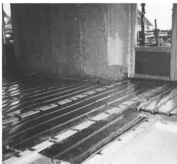
Figur 26. Golvbjälklaget med plåtkassetterna för golvvärmslingorna.
