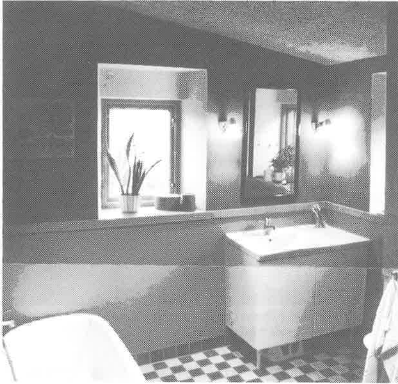
Figur 29. Badrummet med träullsplattor i taket.
