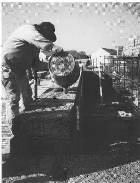
Figur 23. Istället för brukskanna använde murarna hinkar vid murandet.
